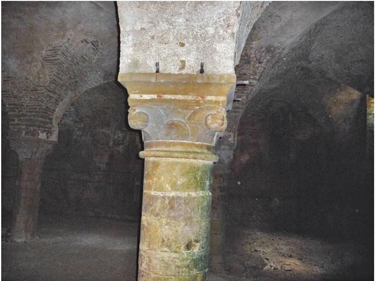
Cave sous la grange, colonne.
