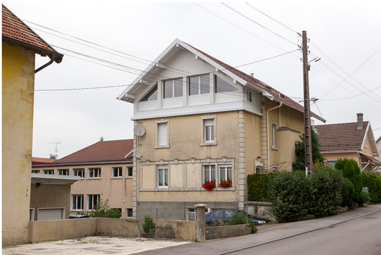
Maison : façades antérieure et latérale gauche.
