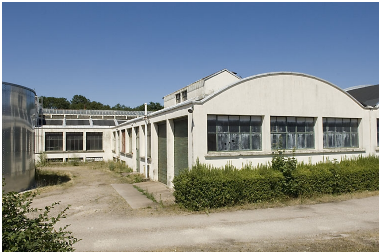
Détail d'un atelier de fabrication.
