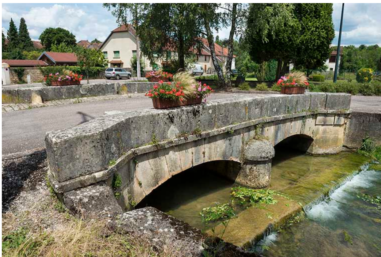
Face sud, vue depuis l'ouest.
