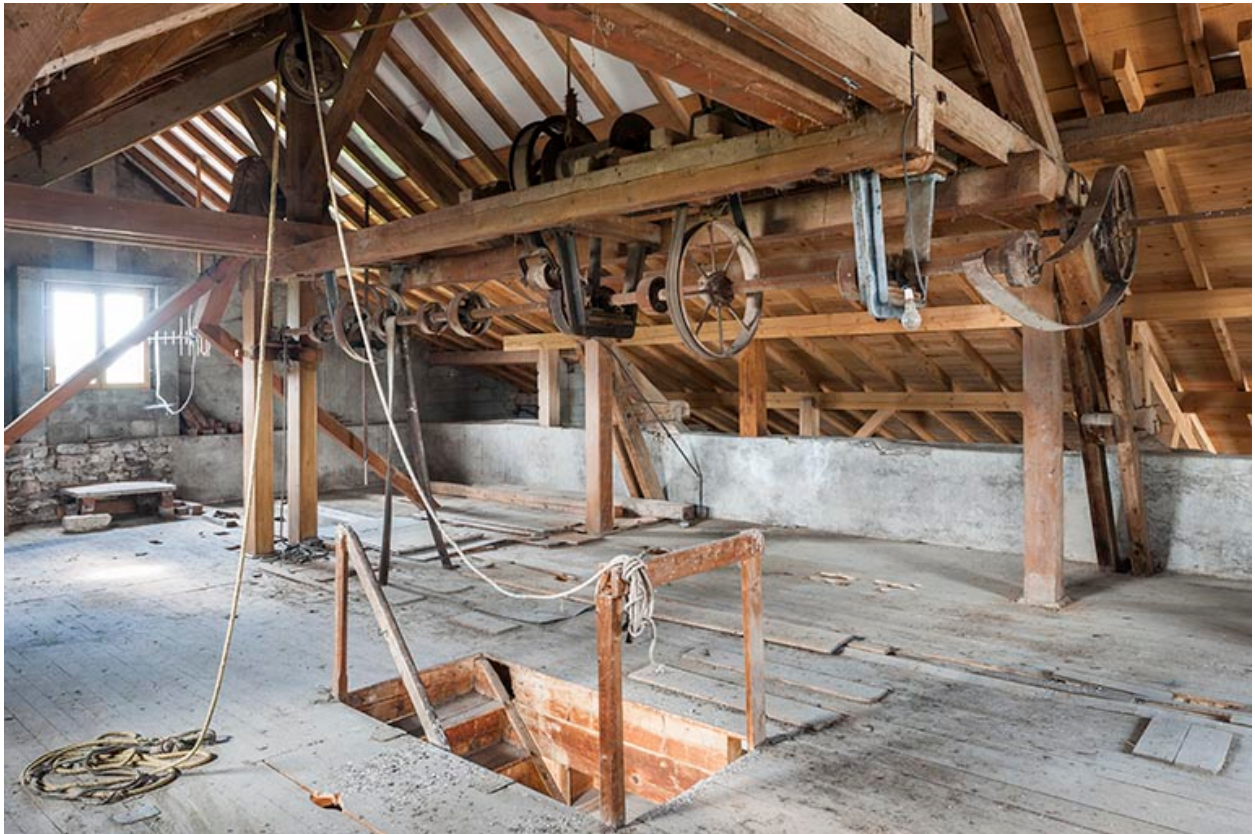
Etage en surcroît. Vue d'ensemble.
