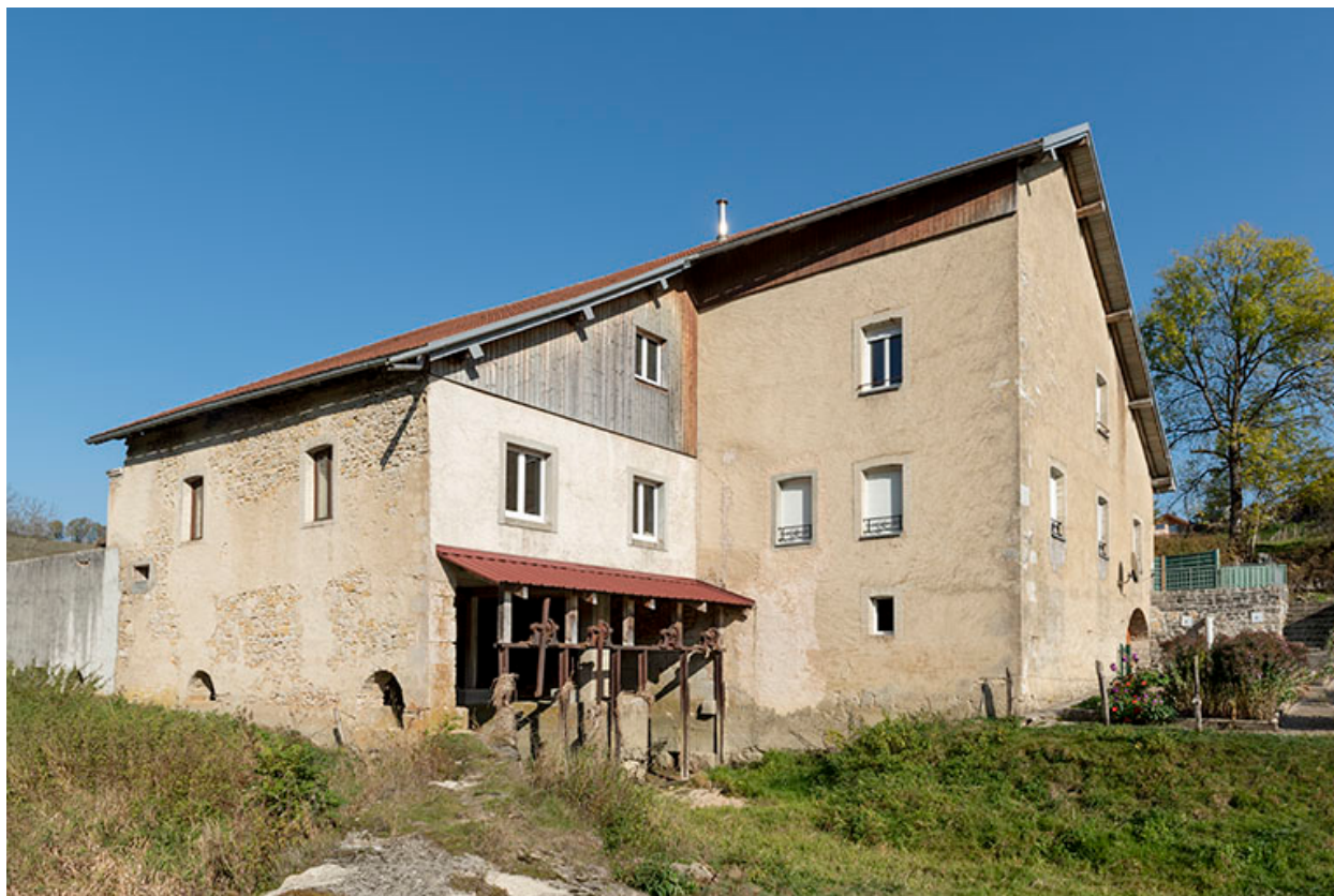
Moulin : façades postérieure et latérale gauche.
