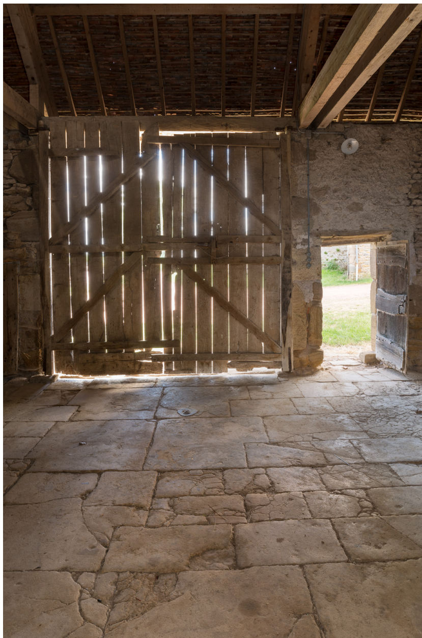
Bâtiment agricole. Vue intérieure de la remise.
