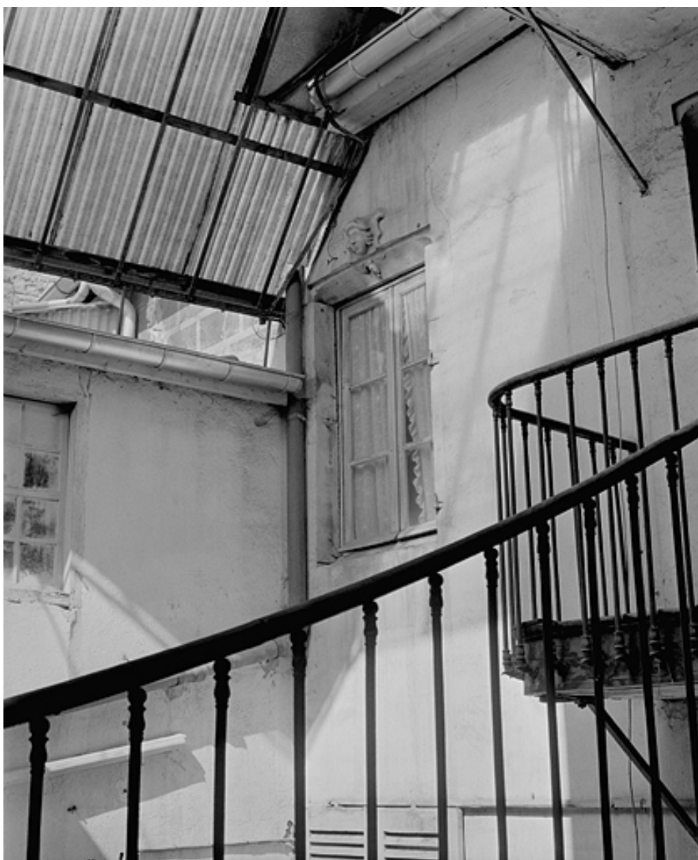
2e étage, fenêtre de gauche.
