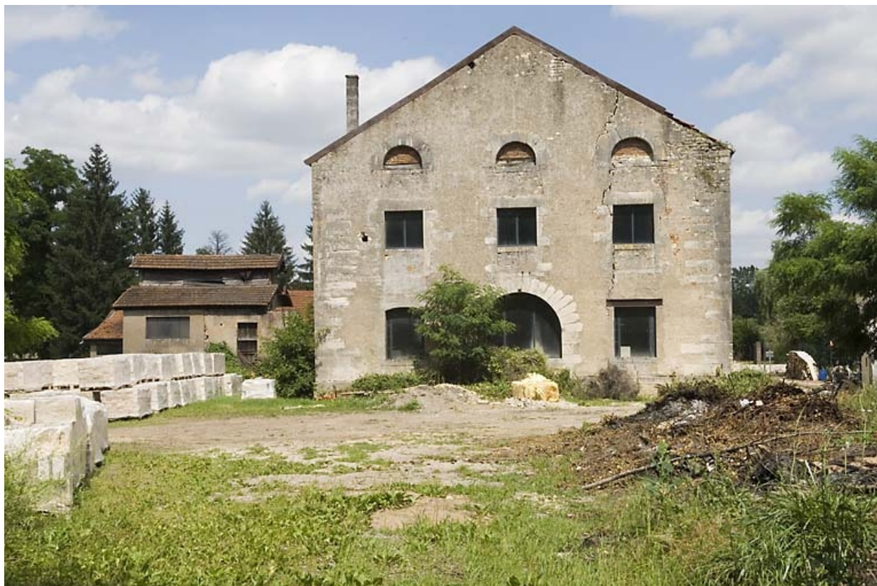
Pignon du bâtiment du haut fourneau ouest.
