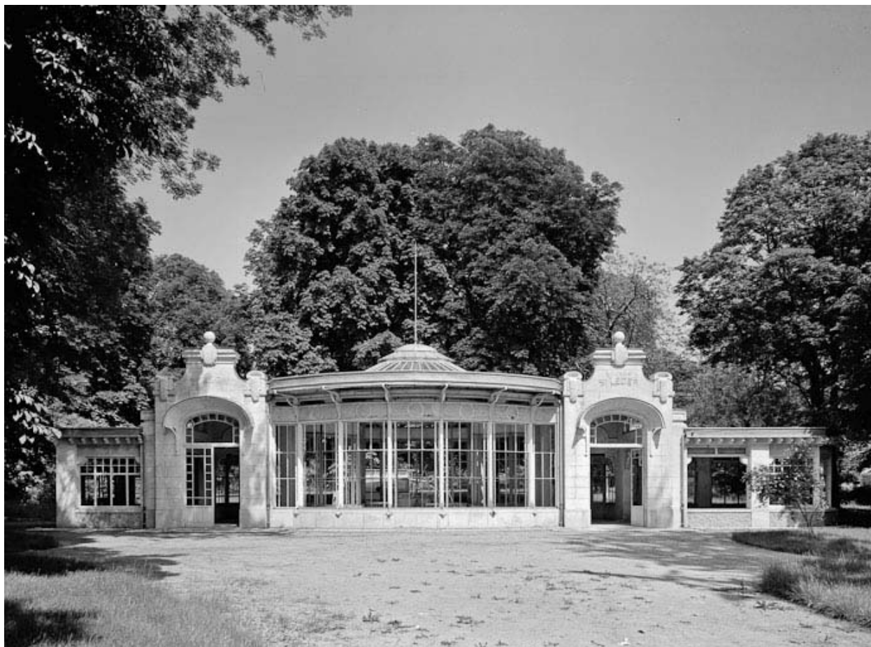
Façade ouest, vue en 1984.
