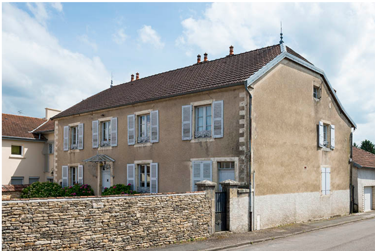
Façade principale, vue de trois quarts.
