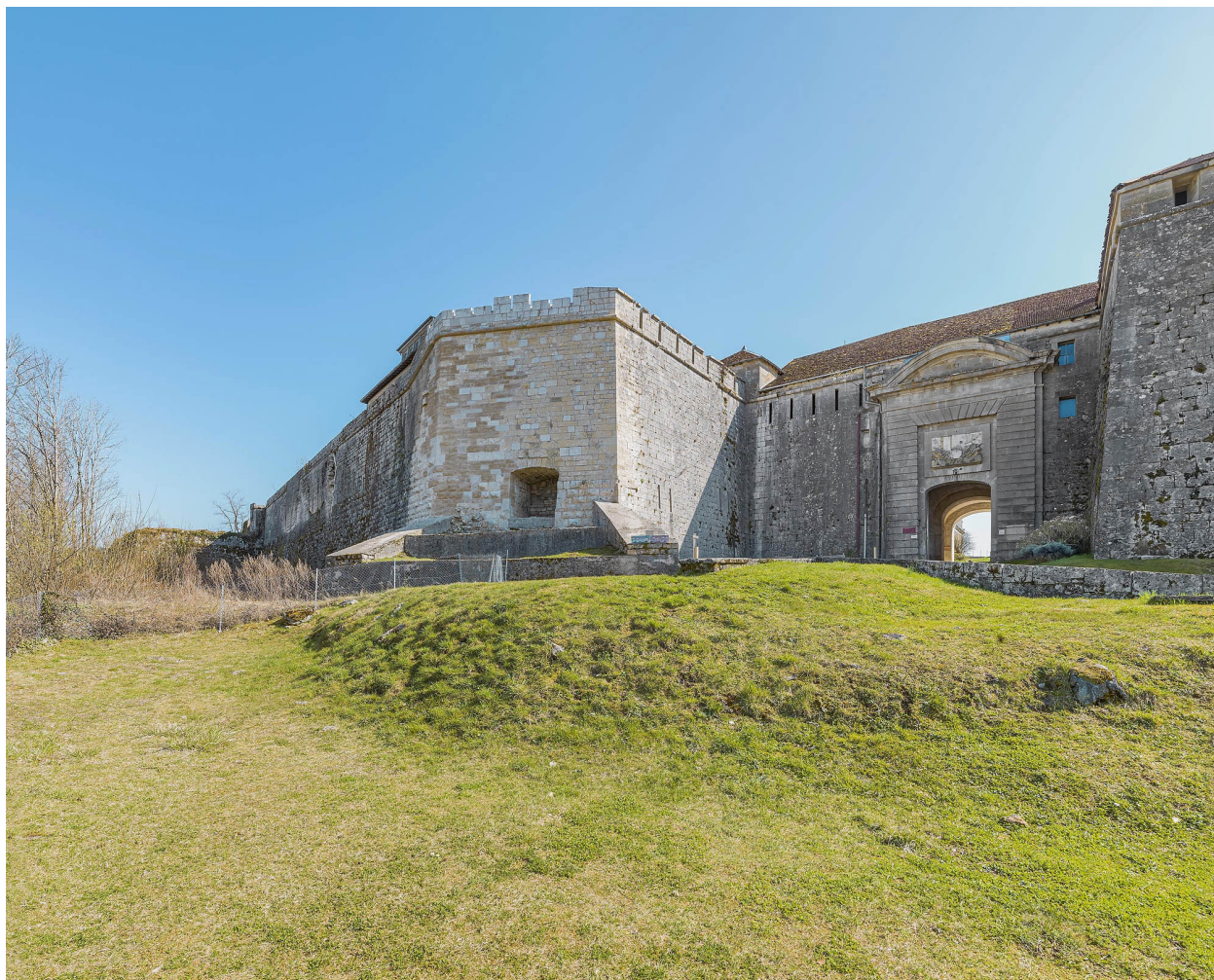
Les bastions encadrant l'entrée principale du fort.
