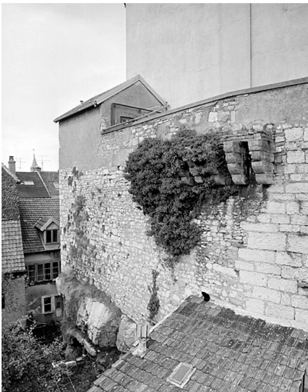
Enceinte. Partie sous le Vieux Château (f).
