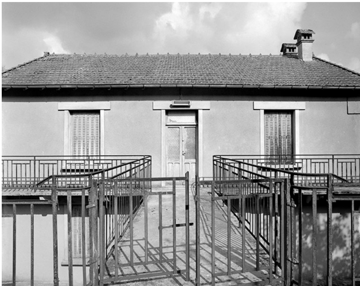
Façade antérieure du logement d'ouvriers.
