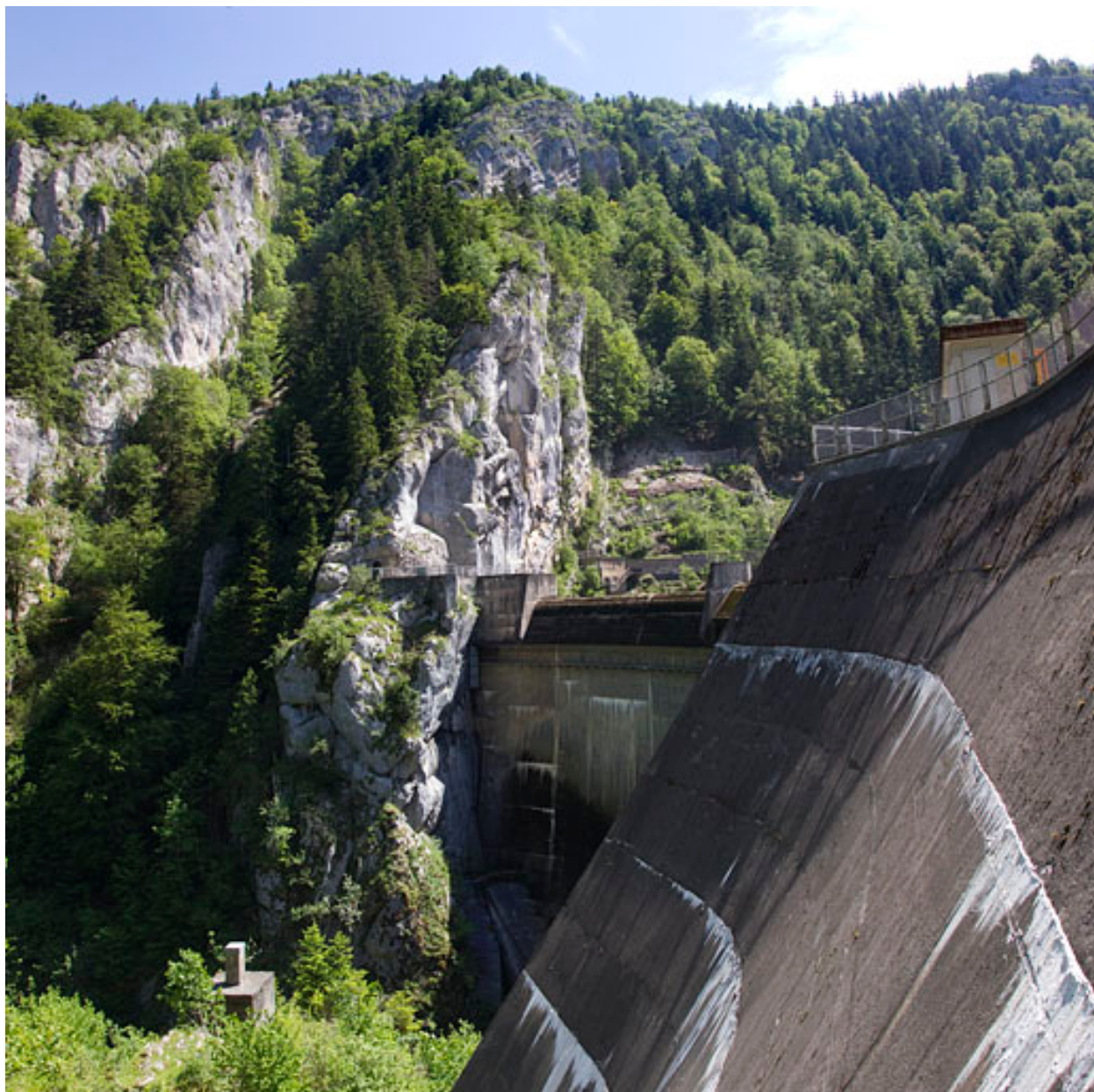
Barrage du Châtelot : ancrage rive droite.
