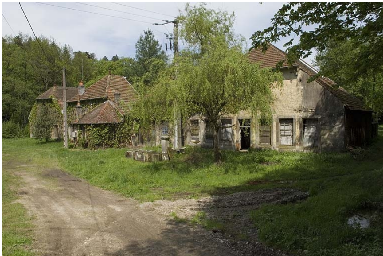
Façades antérieures depuis le sud.
