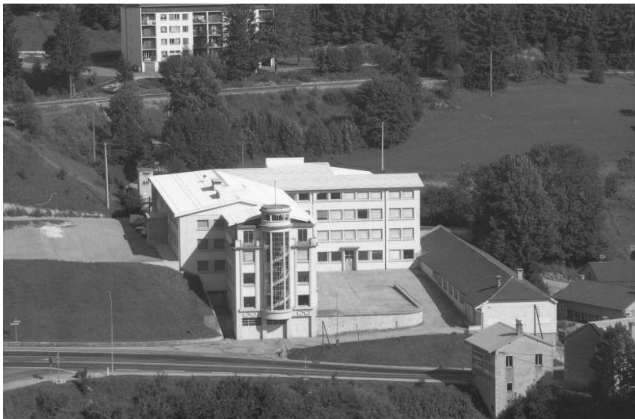
Vue d'ensemble plongeante sur l'usine, depuis l'ouest.
