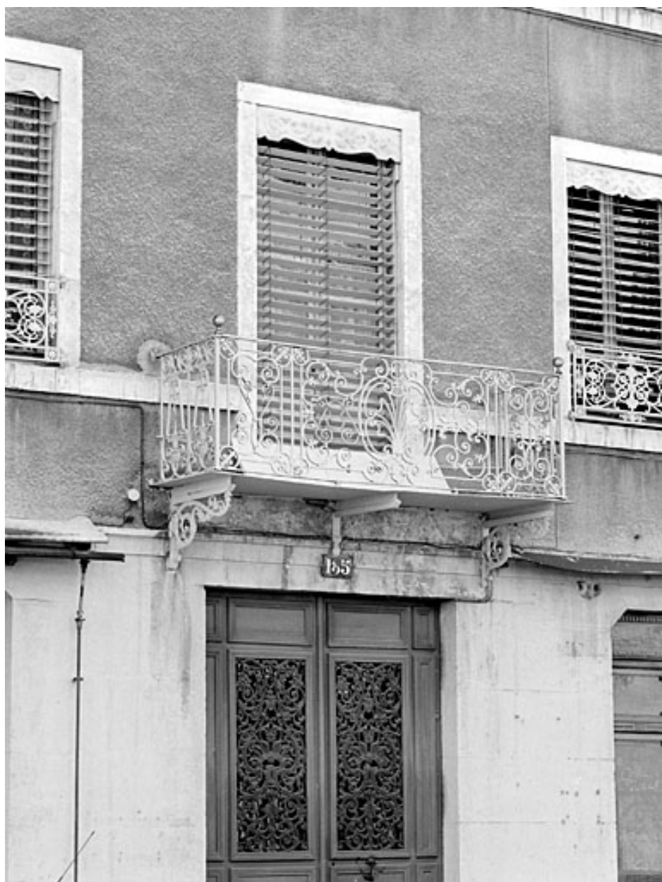
Entrée principale et balcon.
