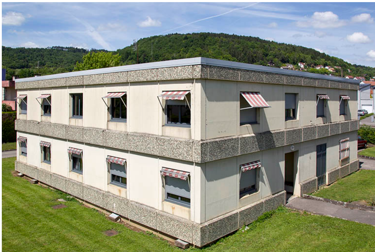
Angle sud des logements.
