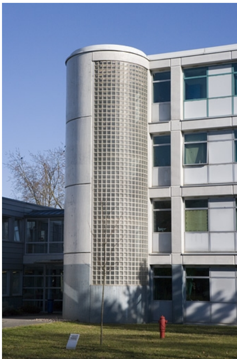
Bâtiment B. Détail de la travée d'escalier.
