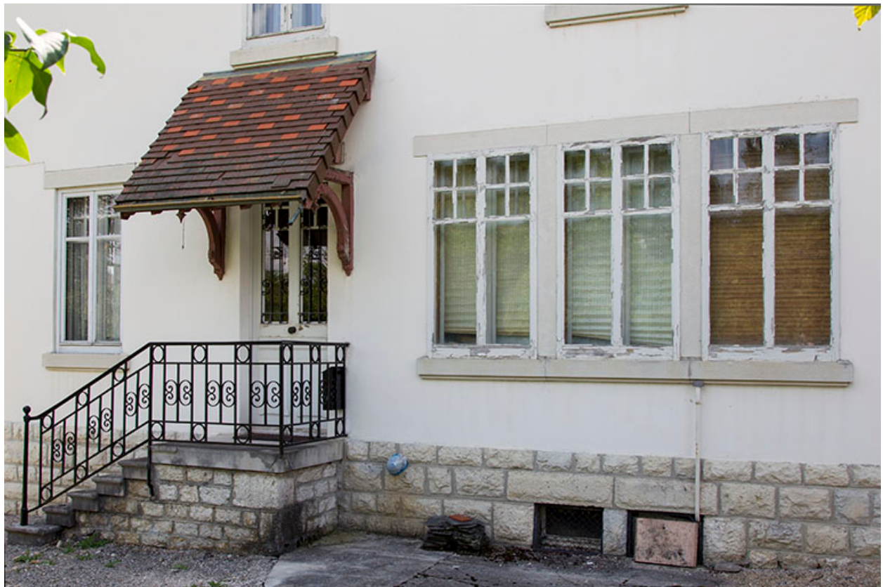
Façade latérale droite : entrée et fenêtres multiples.
