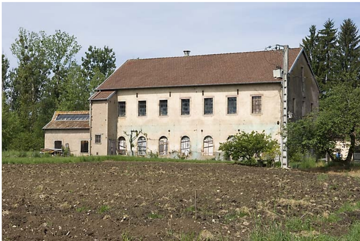
Façade orientale de l'atelier de filature.
