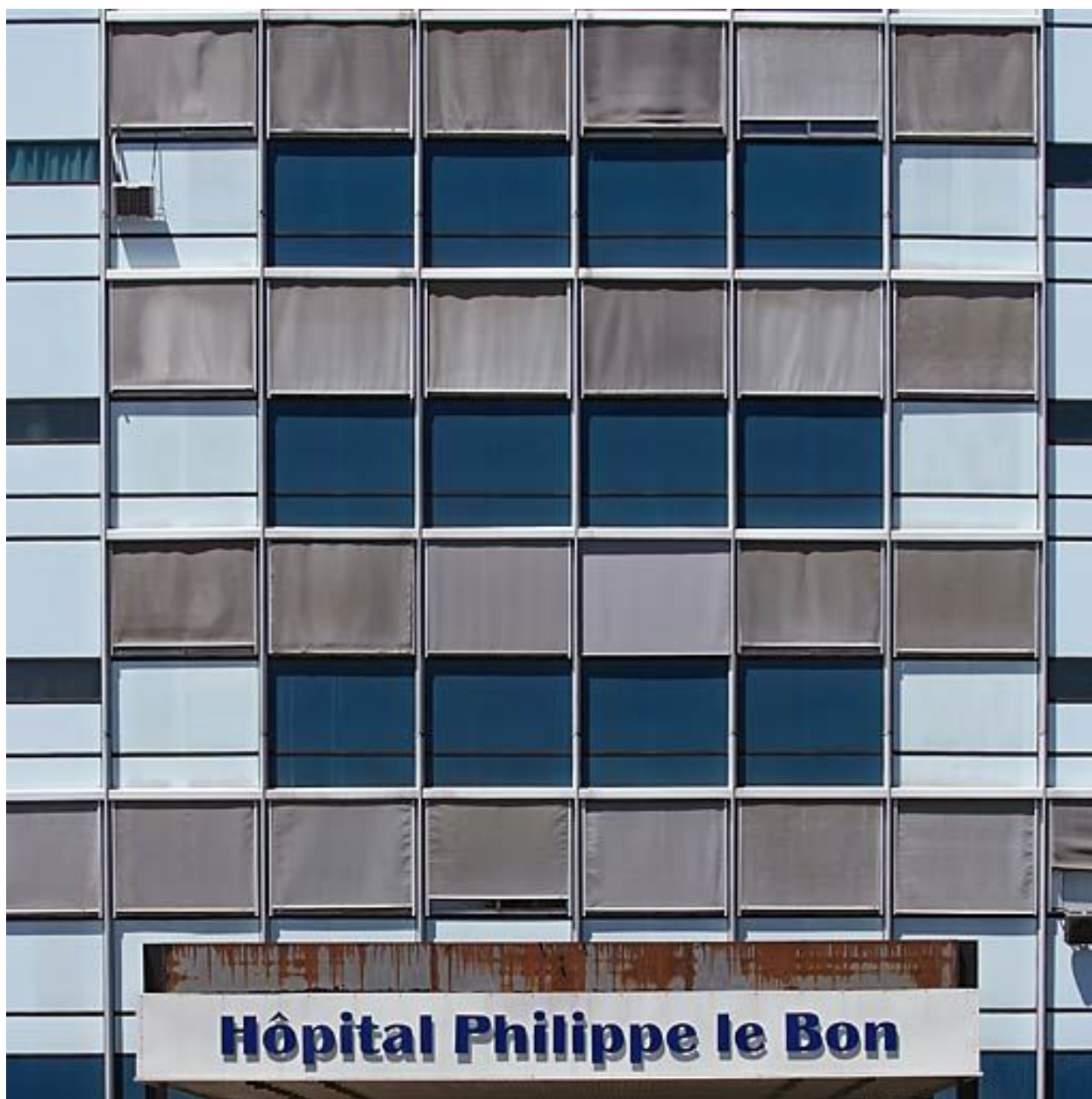
Bâtiment principal, détail de la façade.
