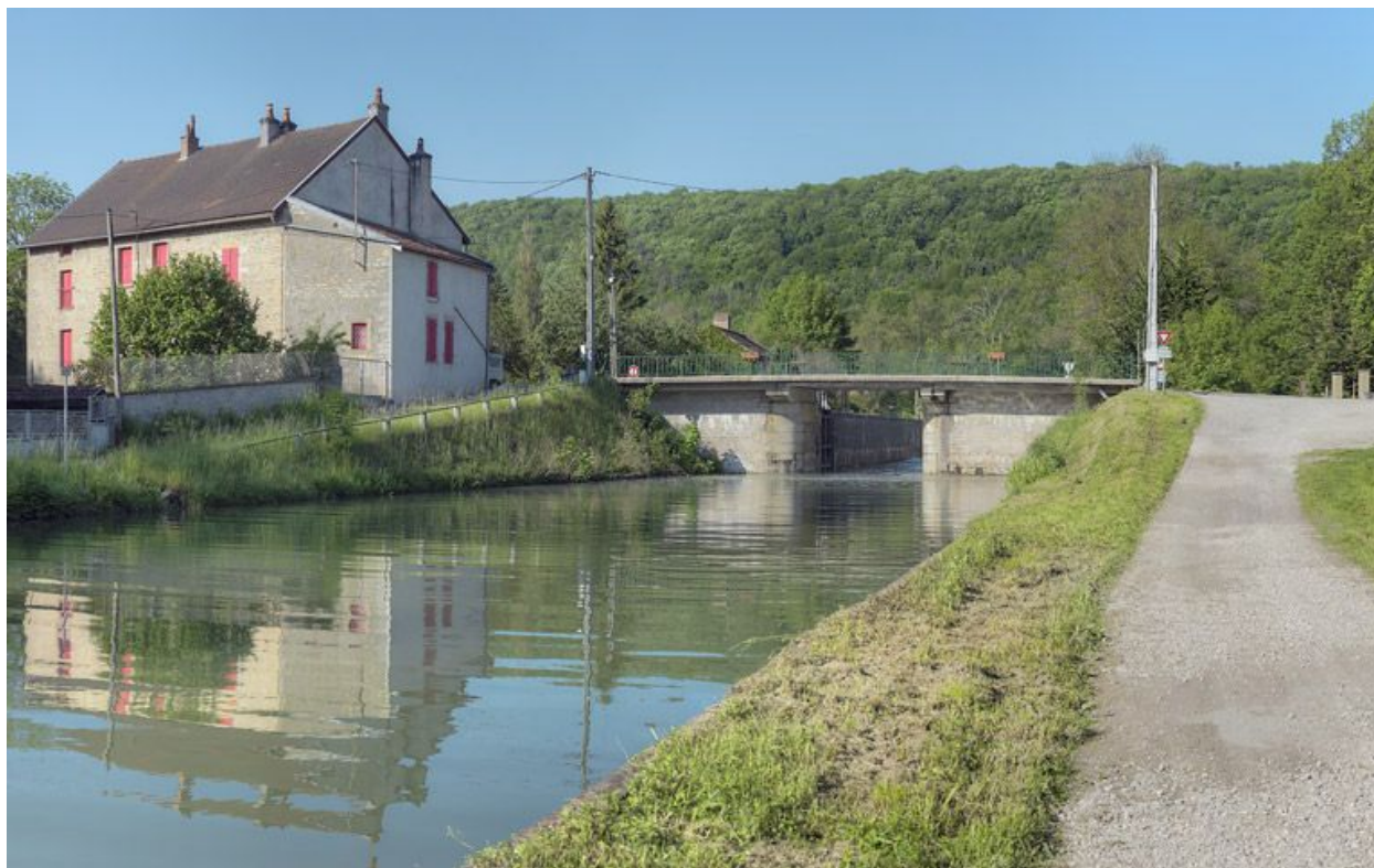
Le pont vu d'aval.
