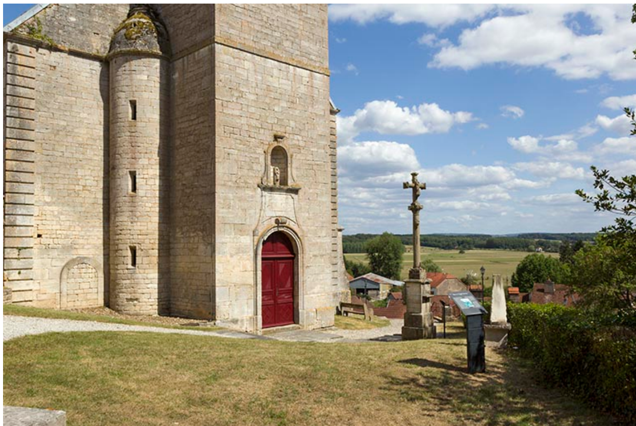
Vue du rez-de-chaussée de la tour-clocher.
