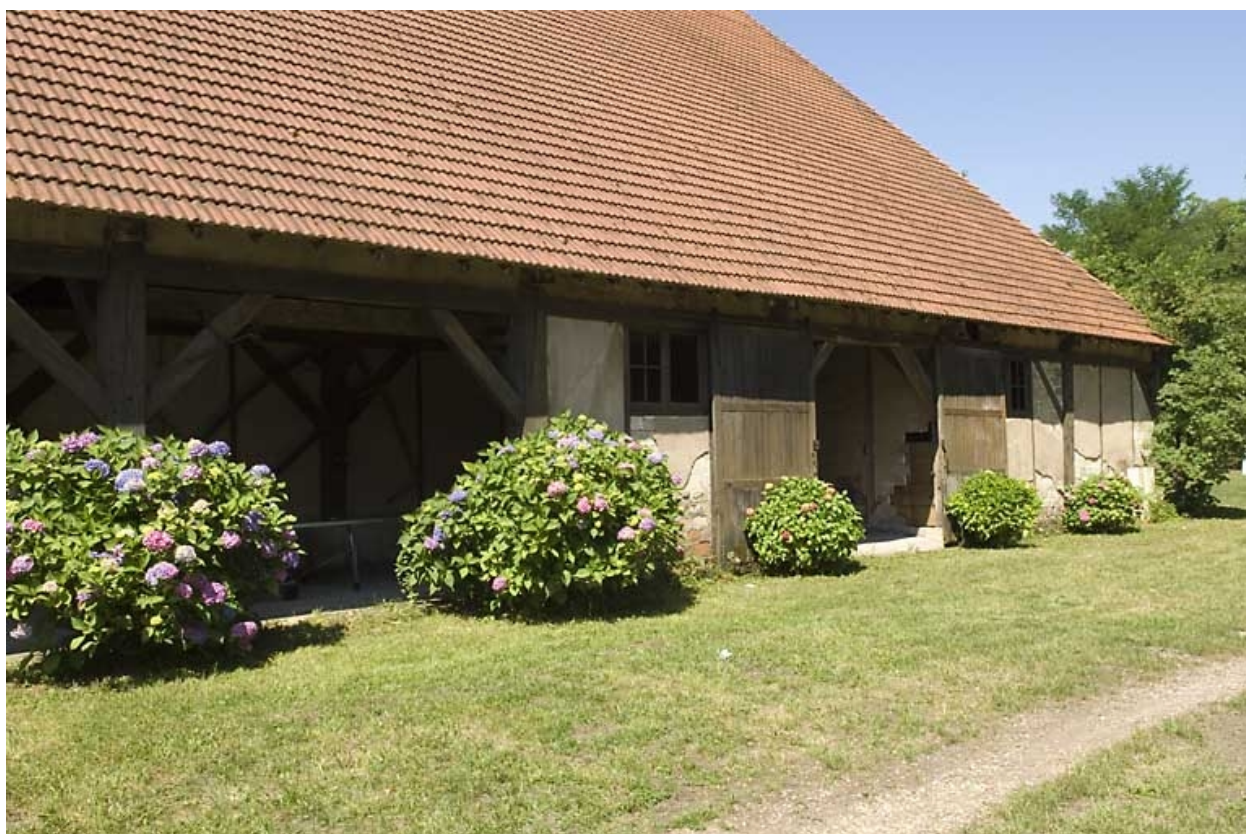
Extrémité nord de la halle à charbon.
