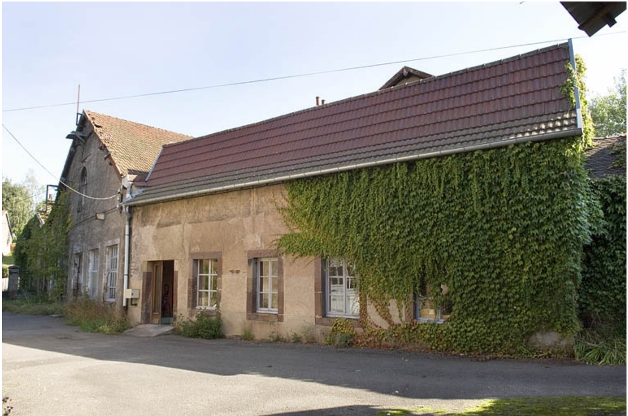
Atelier de réparation vu de trois quarts.
