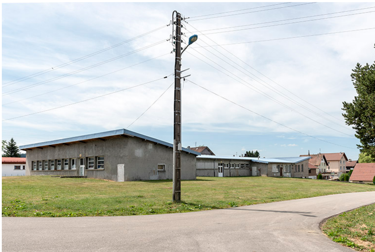
Façades postérieure et latérale droite.
