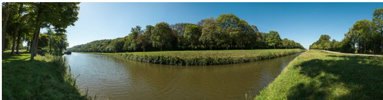
Panorama de l'entrée de la tranchée.
