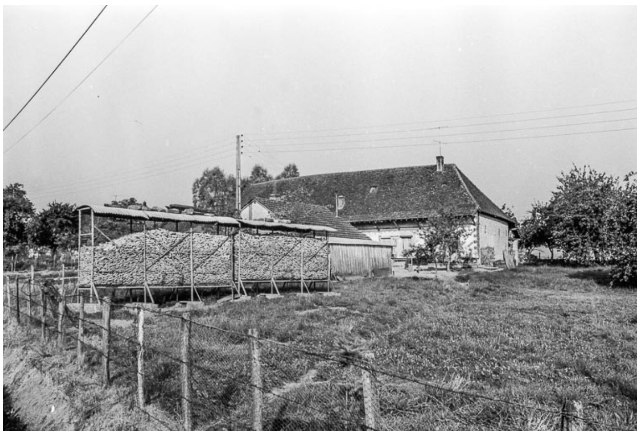
Ferme cadastrée 1956 A1 168 : façade antérieure.
