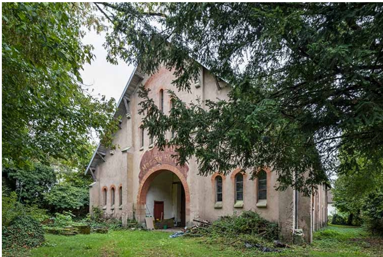
Mur-pignon nord, vue de trois quarts.
