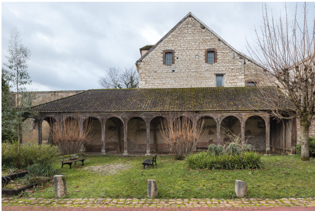
Ancienne halle de 1818-1819.
