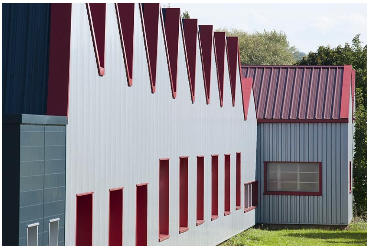
Détail du bardage de la façade sud.
