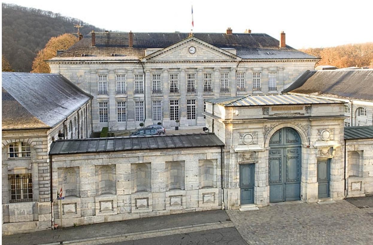
Vue d'ensemble depuis une fenêtre du 9 bis.
