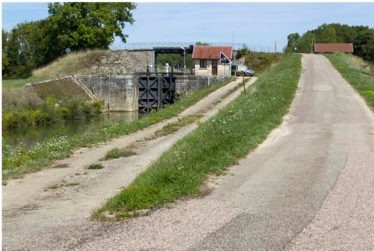
Vue du site d'écluse depuis l'aval.
