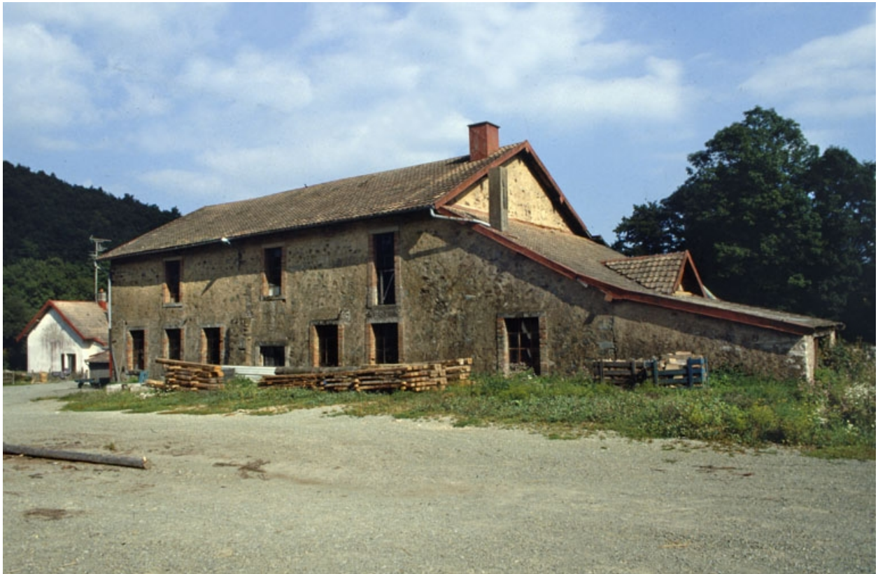
L'atelier de fabrication depuis le sud-est.
