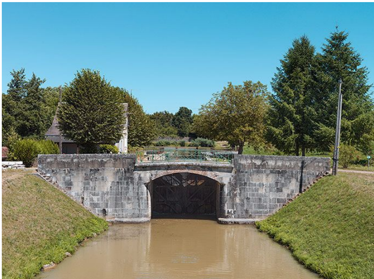
Vue d'ensemble du pont.
