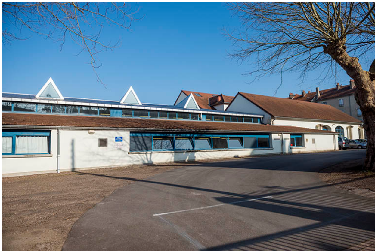
Détail de façade ouest des ateliers.
