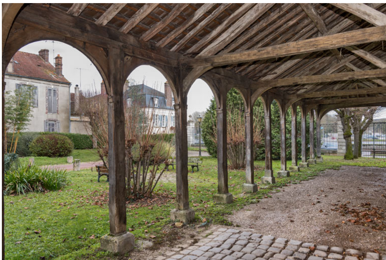
Ancienne halle : vue intérieure avec charpente.
