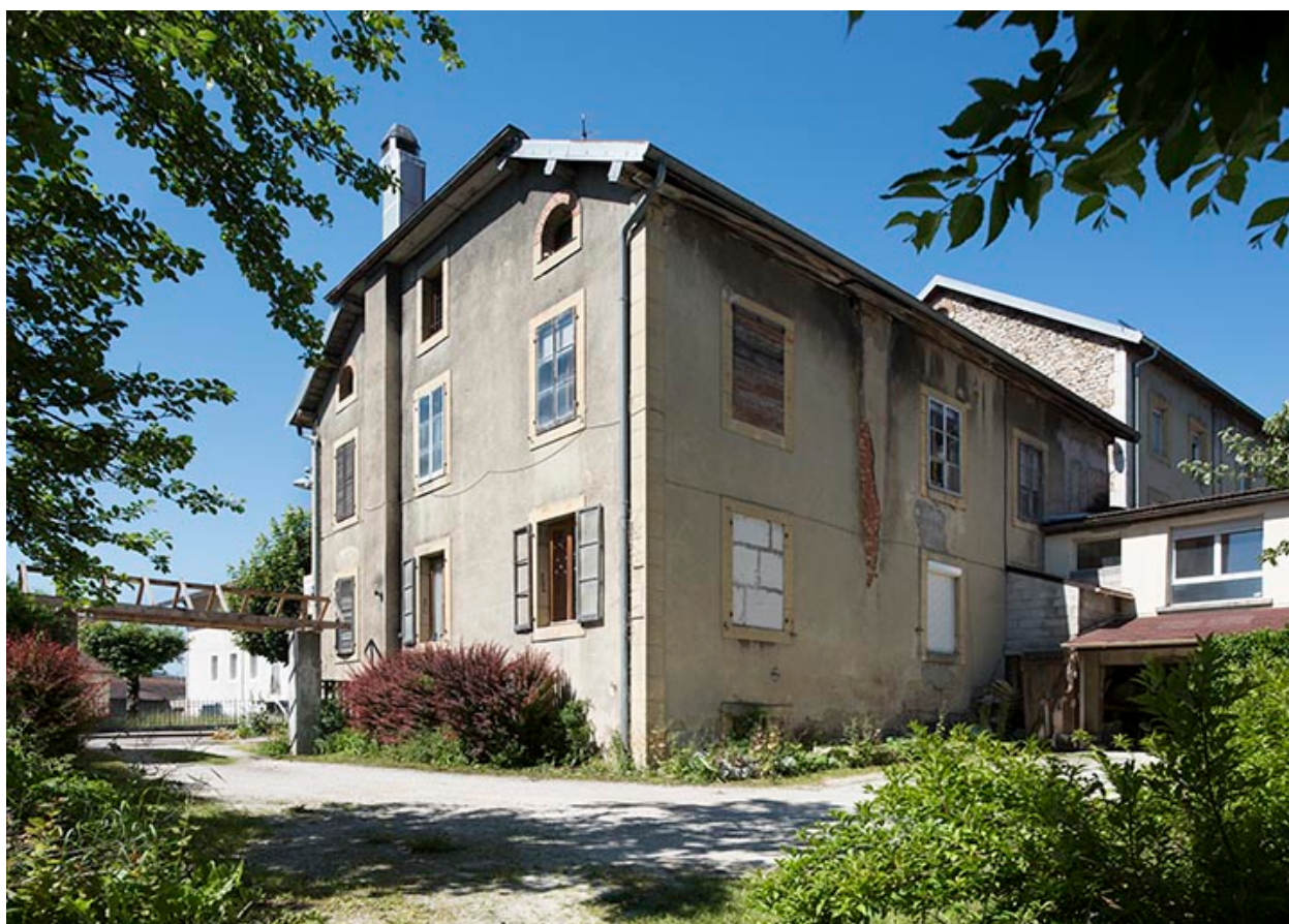
Façades postérieure et latérale droite.
