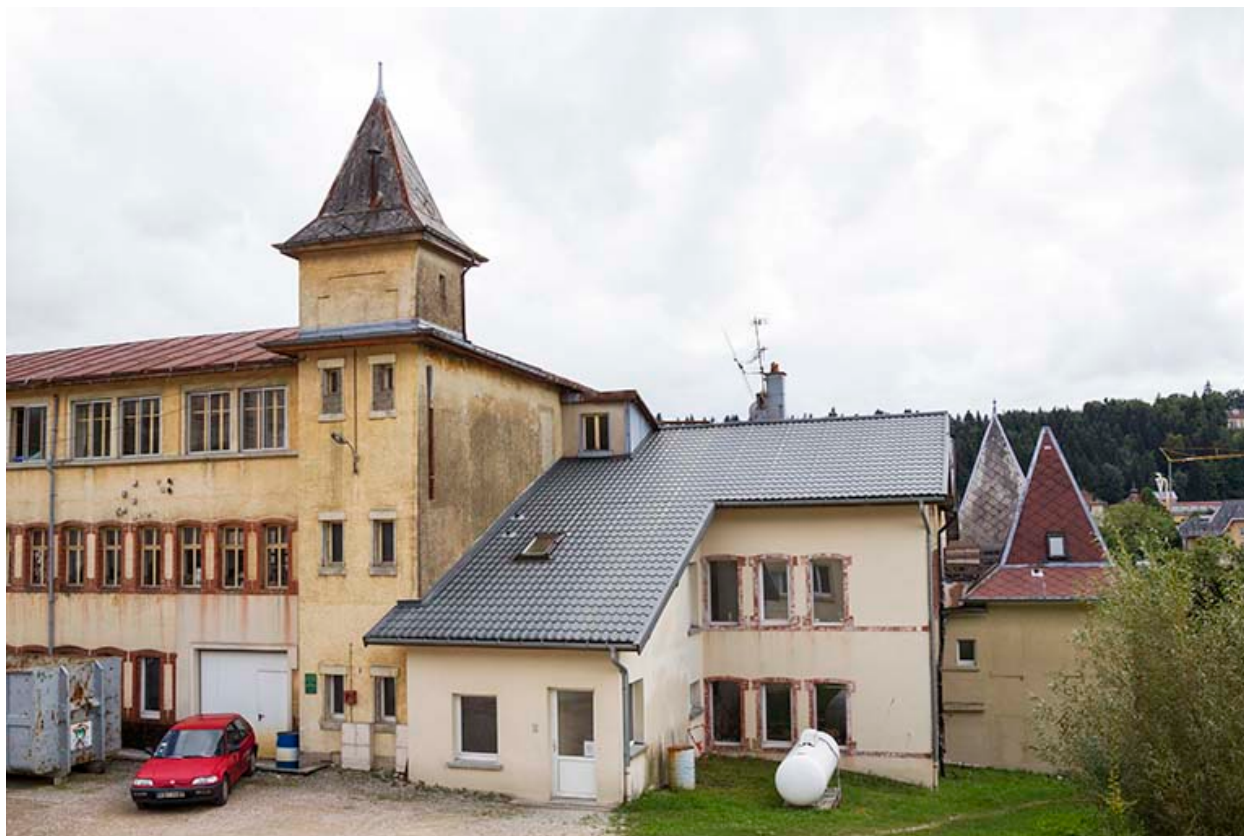
Atelier : façade nord.
