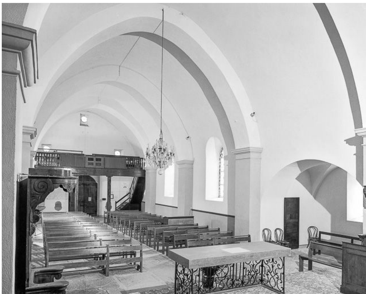
Nef vue depuis le chœur.
