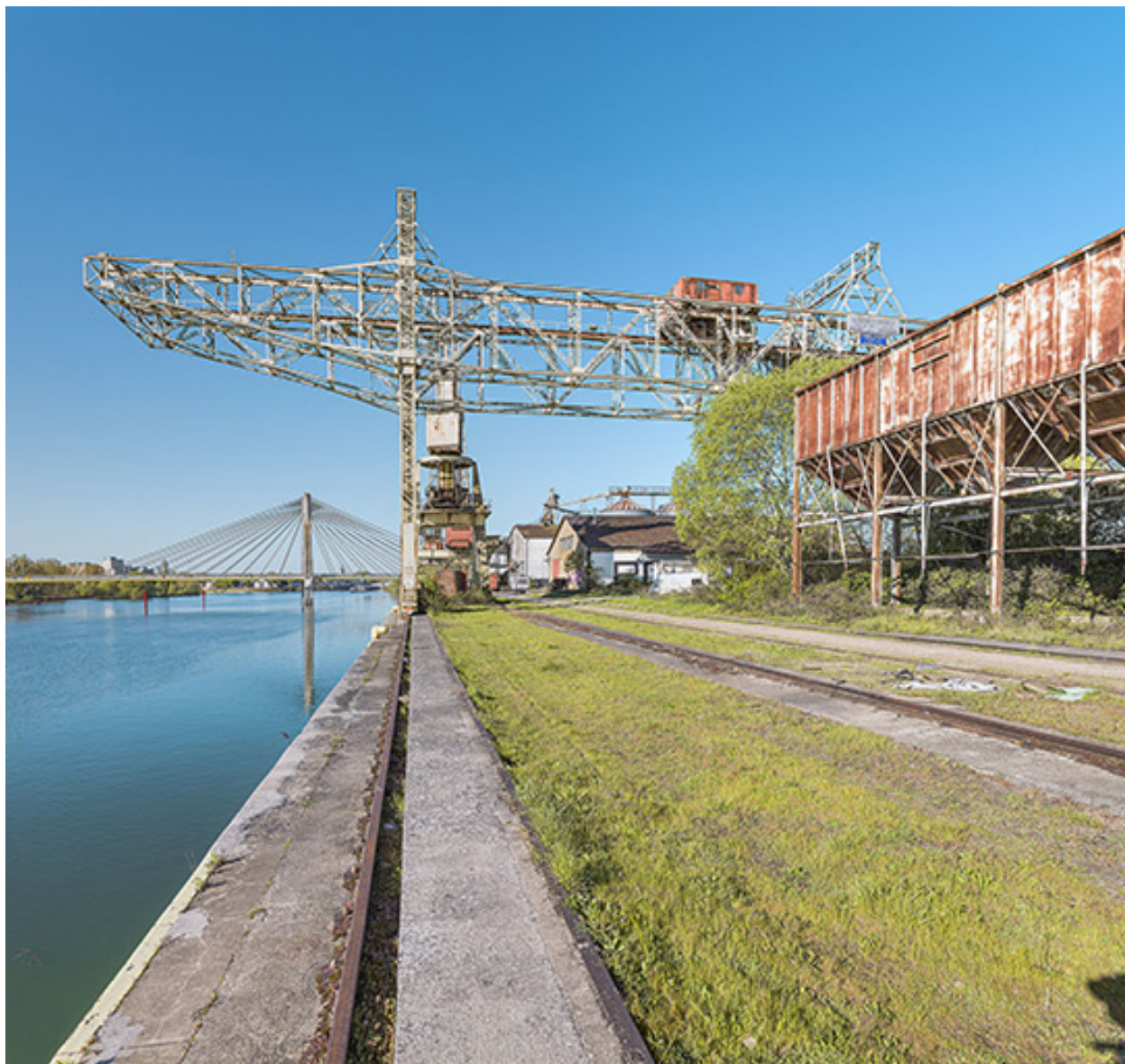
Pont-portique et trémies, le long du quai.
