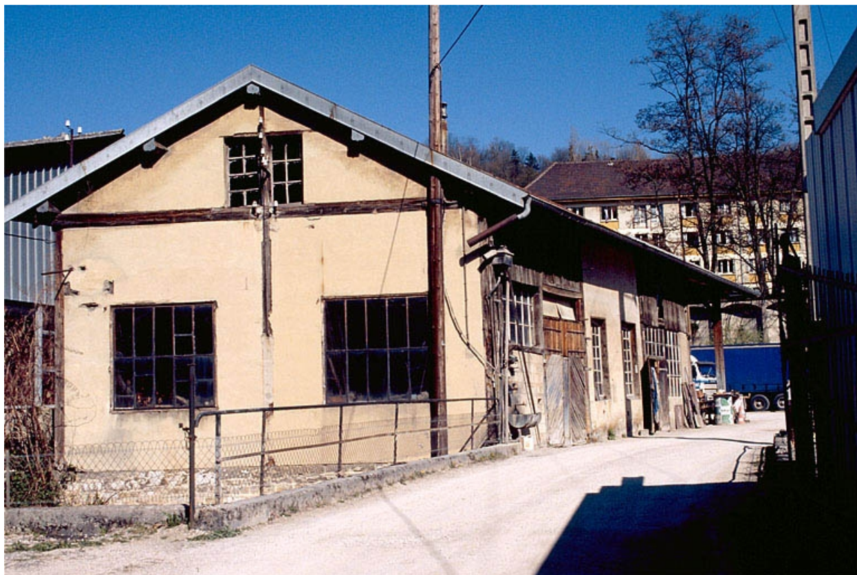
Atelier de réparation depuis la rive gauche.
