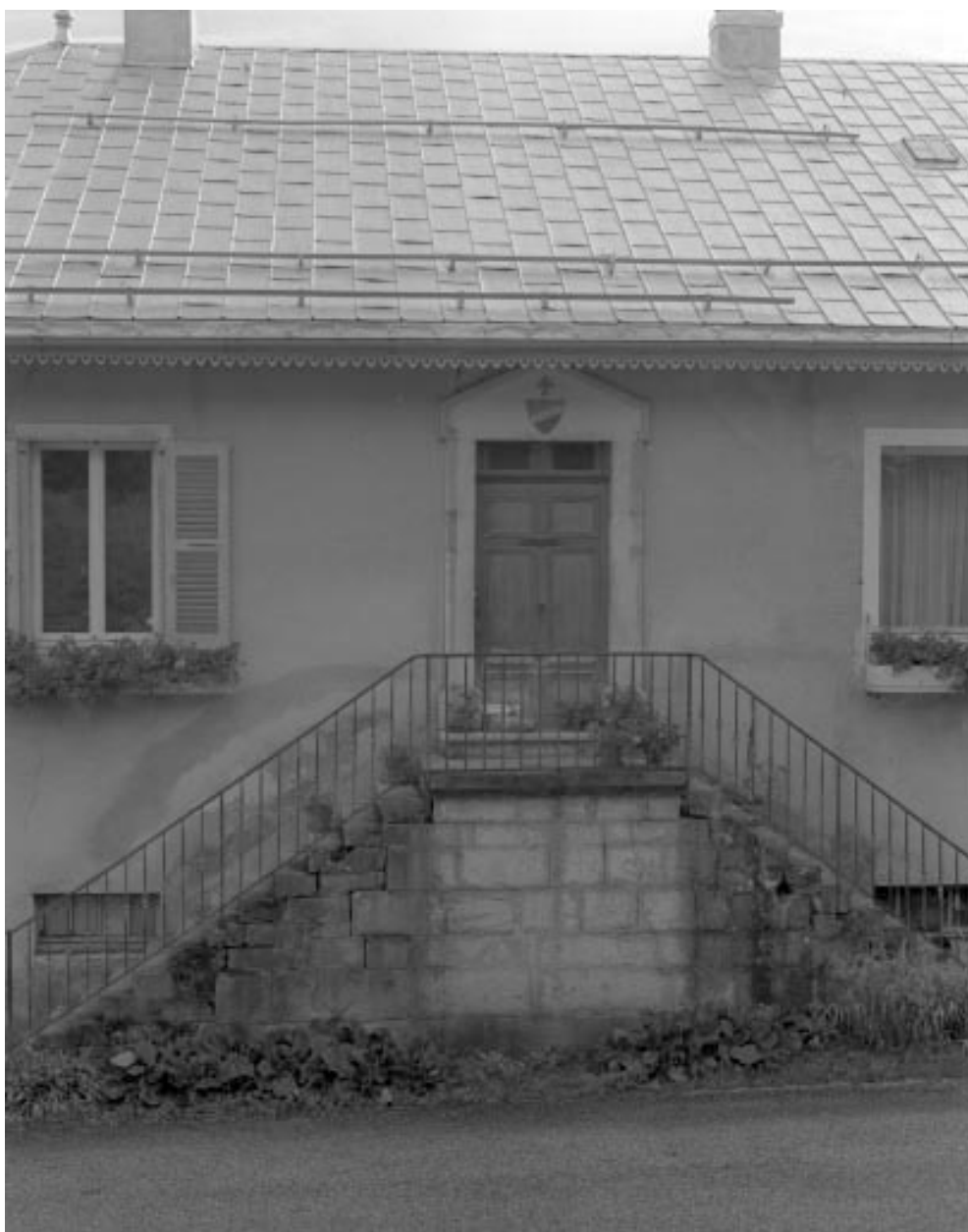
L'escalier menant au logis.
