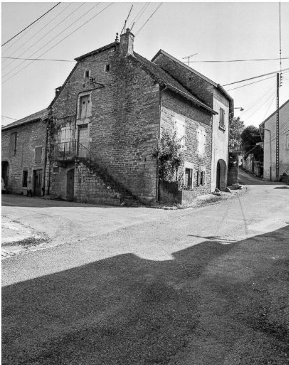
Maison de vigneron située rue de l'Eglise.
