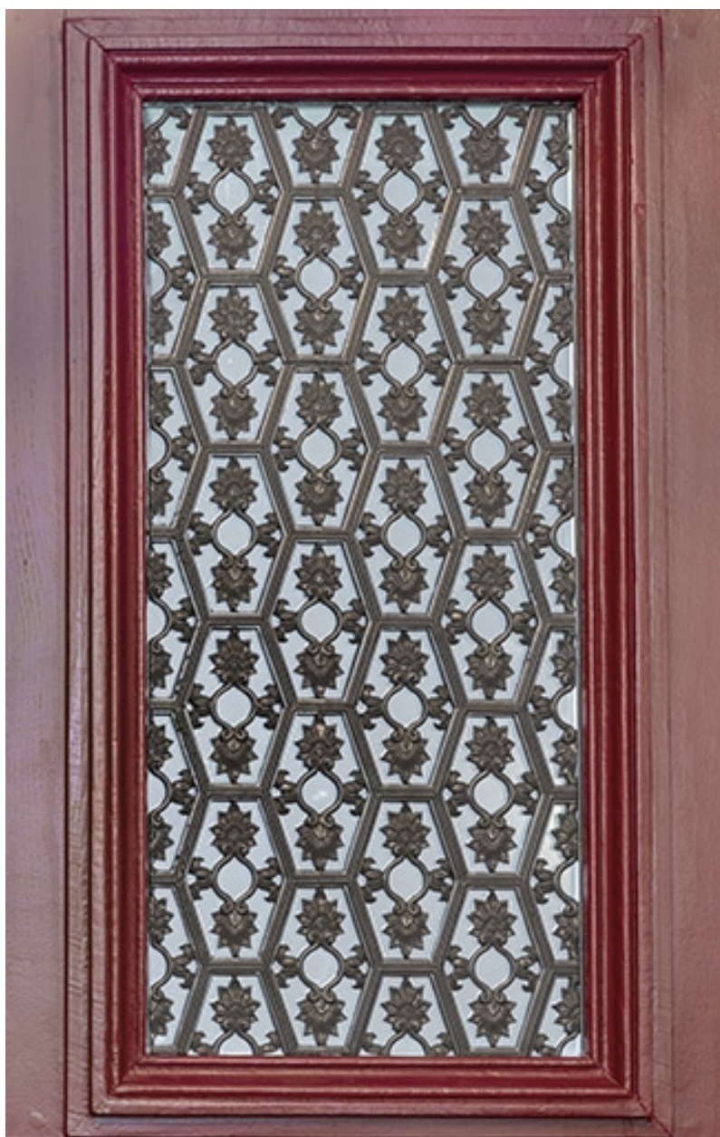
Vestibule, porte côté cour : grille en fonte.
