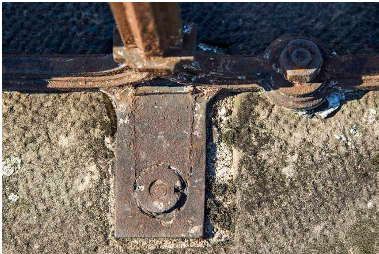
Détail de l'assemblage du garde-corps sur le tablier du viaduc.
