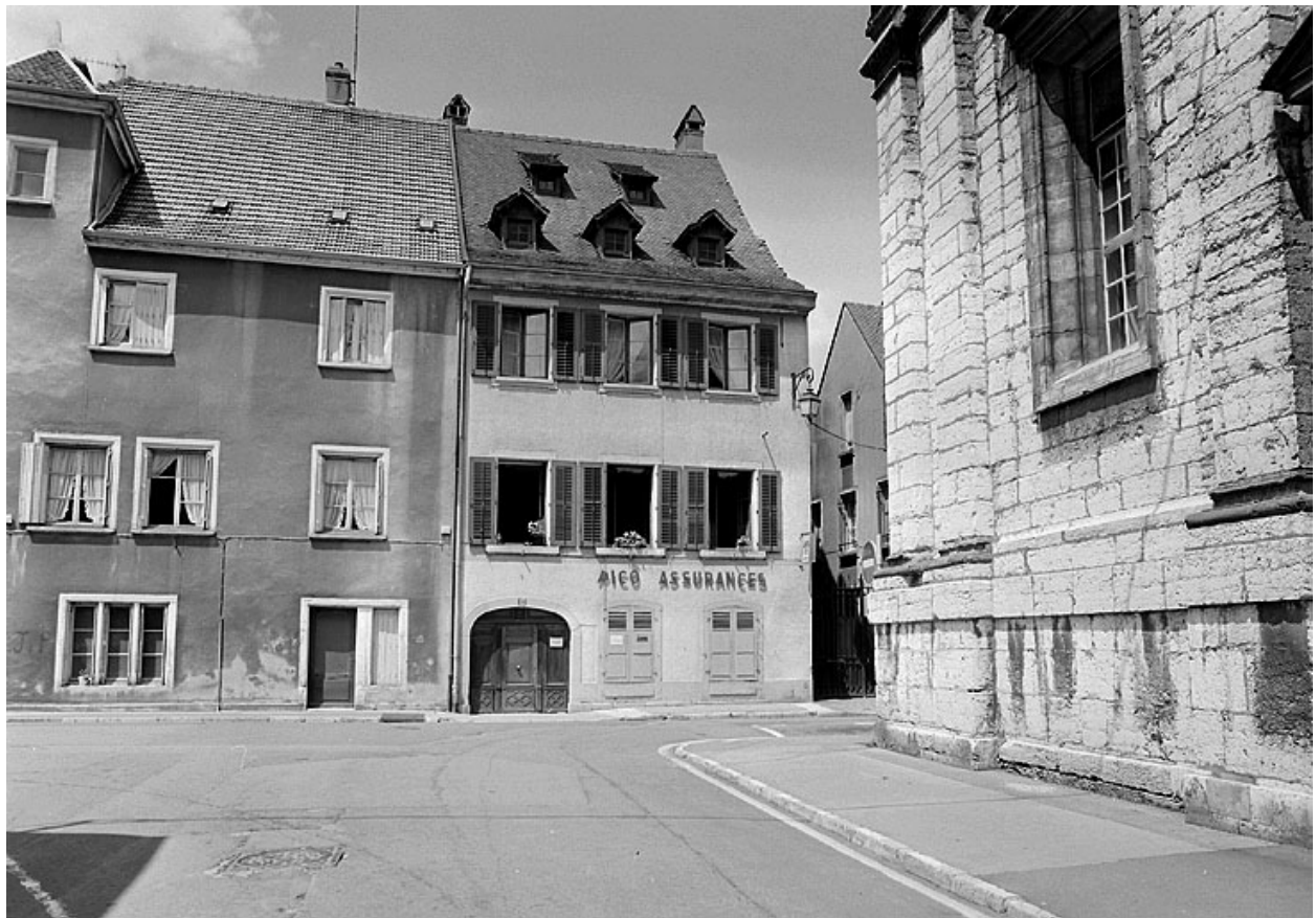
Façade principale sur la rue Saint-Martin.
