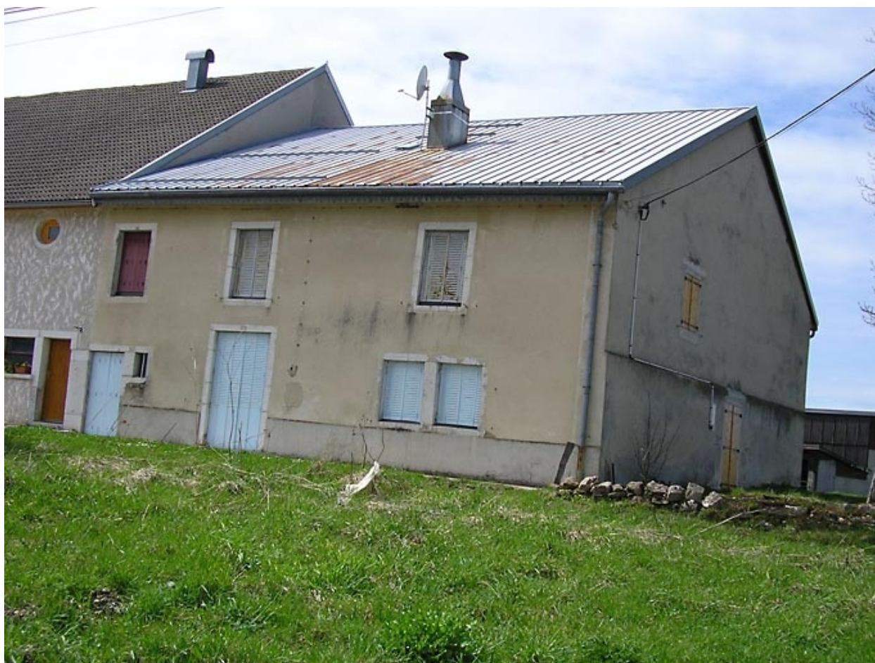
Façade postérieure et pignon sud-ouest.
